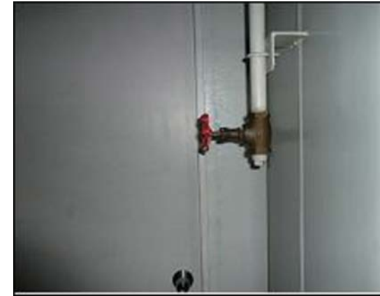
ハンドルの向きが危険
